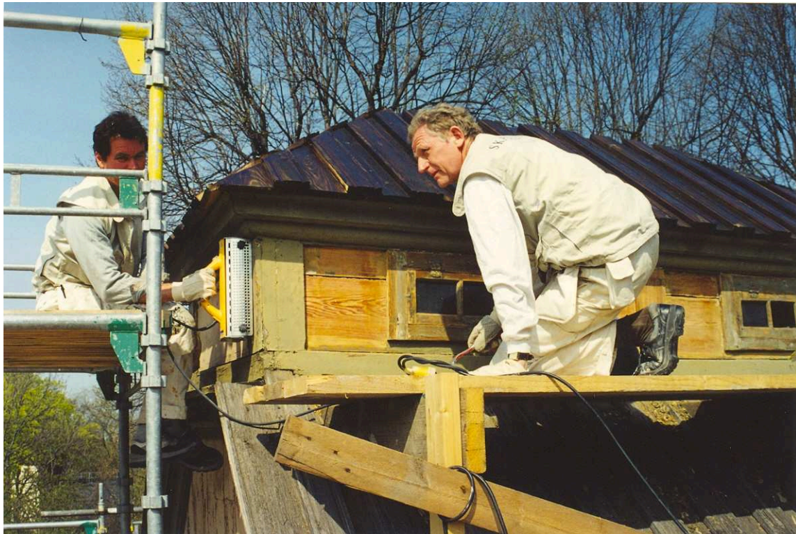
Frank och Lasse tar bort färg med Speedheater. Film nr. 2925. Foto Karin Blent
